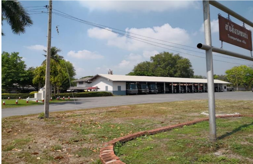
ภาพที่ 5 จุดติดตั้งระบบโซลาร์เซลล์บนหลังคา (Solar Rooftop) บริเวณกลุ่มอาคารโรงเก็บรถยนต์และโรงรถ
