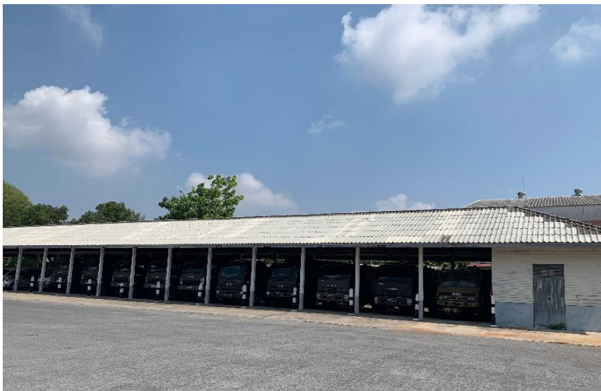
ภาพที่ 6 จุดติดตั้งระบบโซลาร์เซลล์บนหลังคา (Solar Rooftop) บริเวณกลุ่มอาคารคลังสรรพากร
