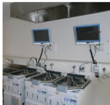
ตัวอย่างตู้ระบายอากาศบริเวณเครื่องล้างอัตโนมัติ
