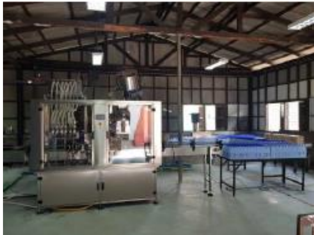
ภาพที่ 2 โครงการดำรงขีดความสามารถและเพิ่มประสิทธิภาพโรงงานแบตเตอรี่ทหารของ กรมการอุตสาหกรรมทหาร ศูนย์การอุตสาหกรรมป้องกันประเทศและพลังงานทหาร (งานปรับปรุงระบบผลิตน้ำกลั่น)
