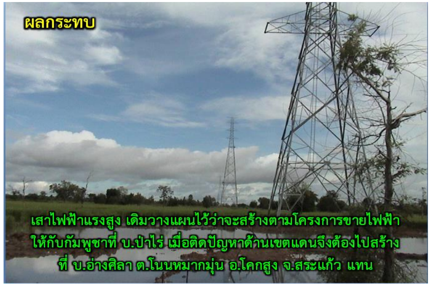
ภาพที่ 9 เสาไฟฟ้าแรงสูง ที่ก่อสร้างบริเวณ บ้านอ่างศิลา 13
